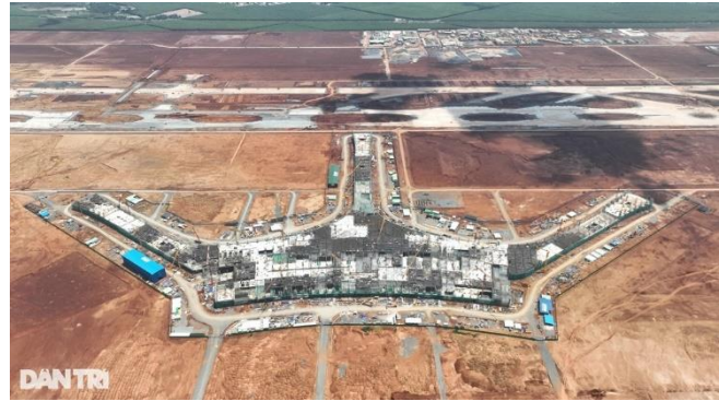
Hiện trạng thi công sân bay Long Thành (Sources: Dân trí)
